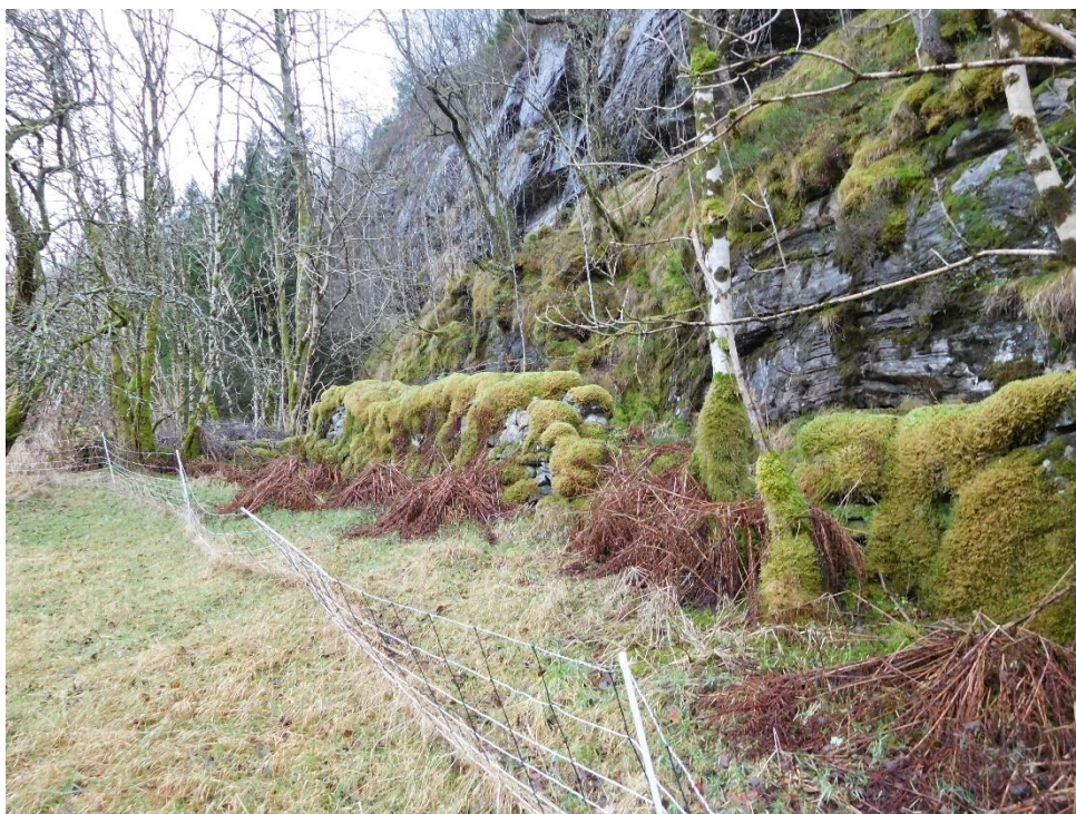
Fig.18: Gammelt moselagt steingjerde i toppen av moreneavsetningen, inn mot fjellfoten til Sandneskletten. Trolig gjerde for fedrift. Fungerer også som sikring mot steinsprang.
