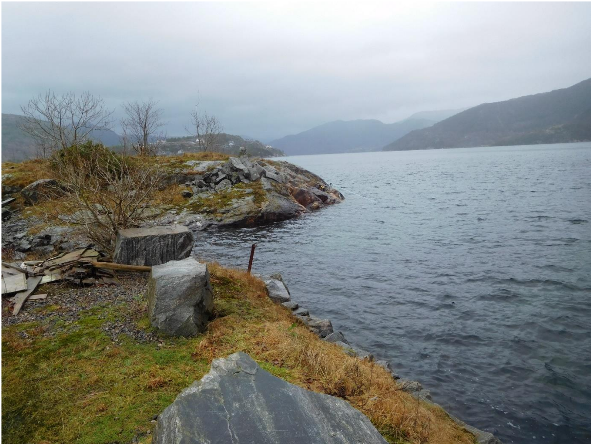
Fig.21: Deler av fyllingsområdet ved Storeskjær. Her vil det være behov for kontroll av leirsedimenter.
