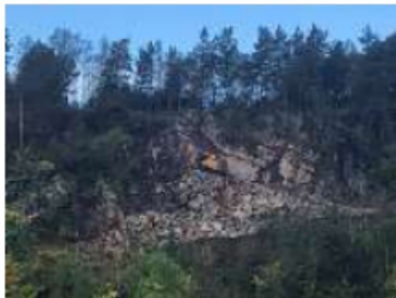
Anleggsveg snart på toppen
