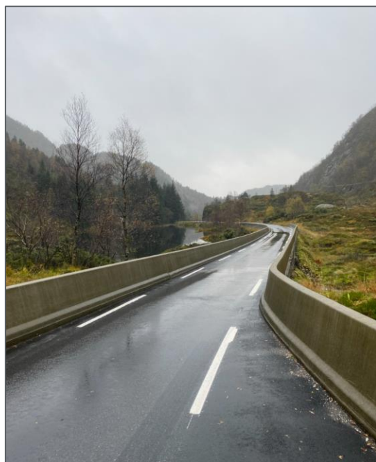
Figur 21: Fv571 - Kringlevegen v/Geirevatnet.
