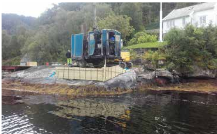
Kjerneboring – fundament til Masfjordbrua
