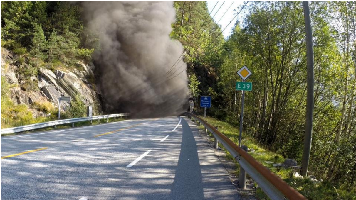
Testing av tunellventilasjon – Matresberg tunnelen E-39
