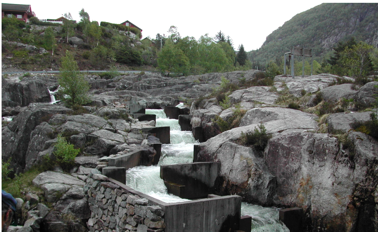
Figur 3. Fisketrapper er et eksempel på tiltak som kan pålegges i medhold av naturforvaltningsvilkårene (foto: Rune Flatby).
