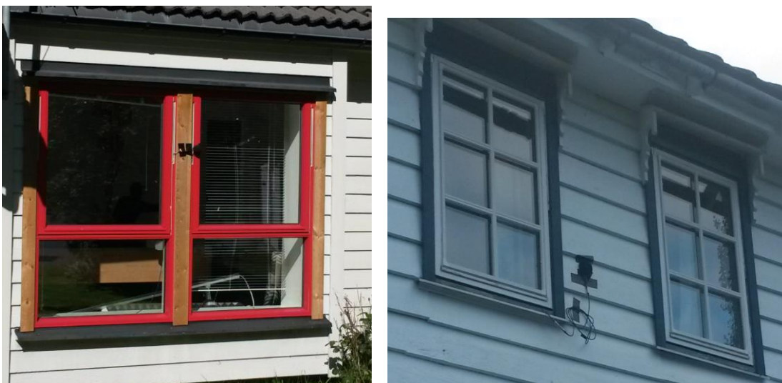
Figur 2: Fasadepunkter hvor mikrofoner er plassert.
