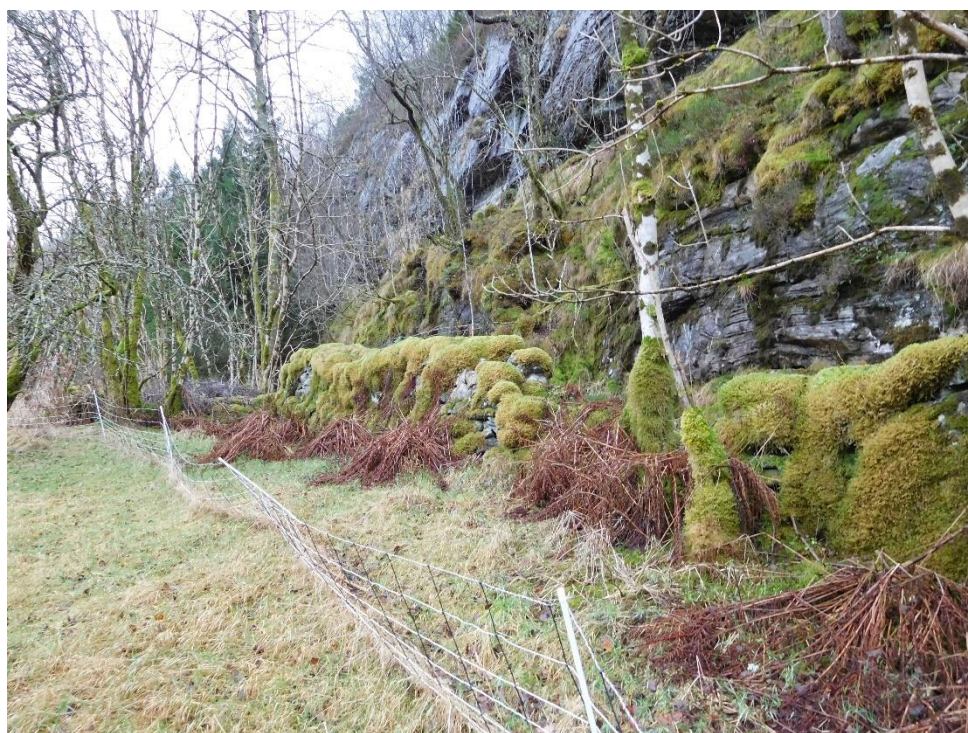
Fig.18: Gammelt moselagt steingjerde i toppen av moreneavsetningen, inn mot fjellfoten til Sandneskletten. Trolig gjerde for fedrift. Fungerer også som sikring mot steinsprang.
