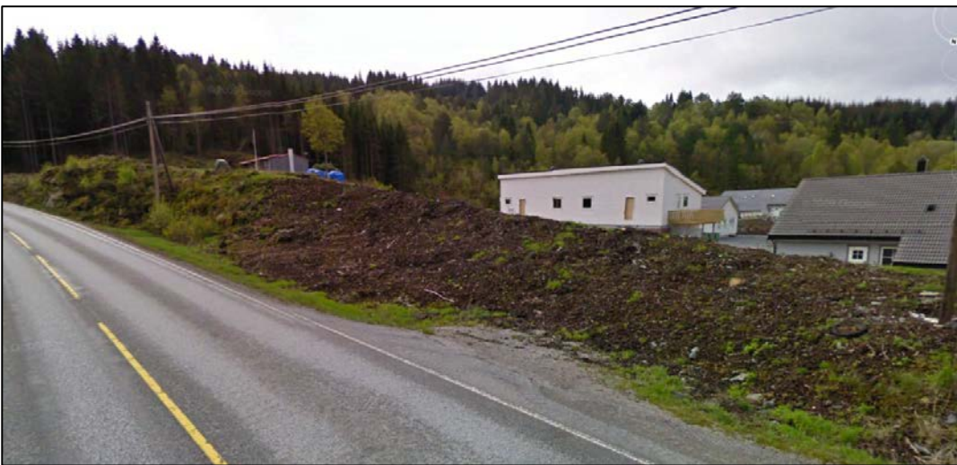
Figur 39. Bilde frå Google Earth som viser støyvoll oppført som avbøtande tiltak i gjeldande plan.
