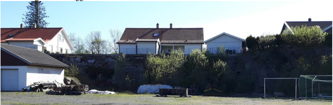
Figur 34 Sagstadvegen 101 midt i bilete. 99 til venstre (over garasje som skal rivast).
