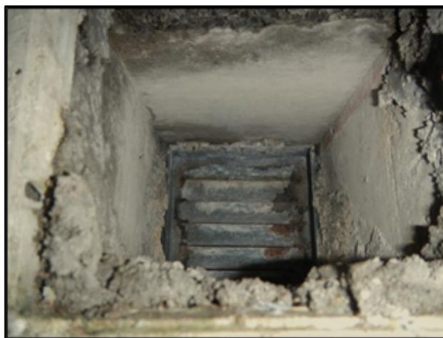
Lufting med ødelagt finmasket netting
