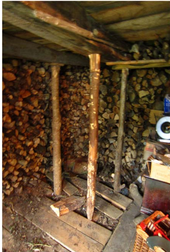
Innvendig støtte for etasjeskilje mellom loft og hovudetasje.
