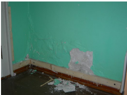
Fuktgjennomtrenging og saltutslag bak brystningspanel i klasserom 7.
