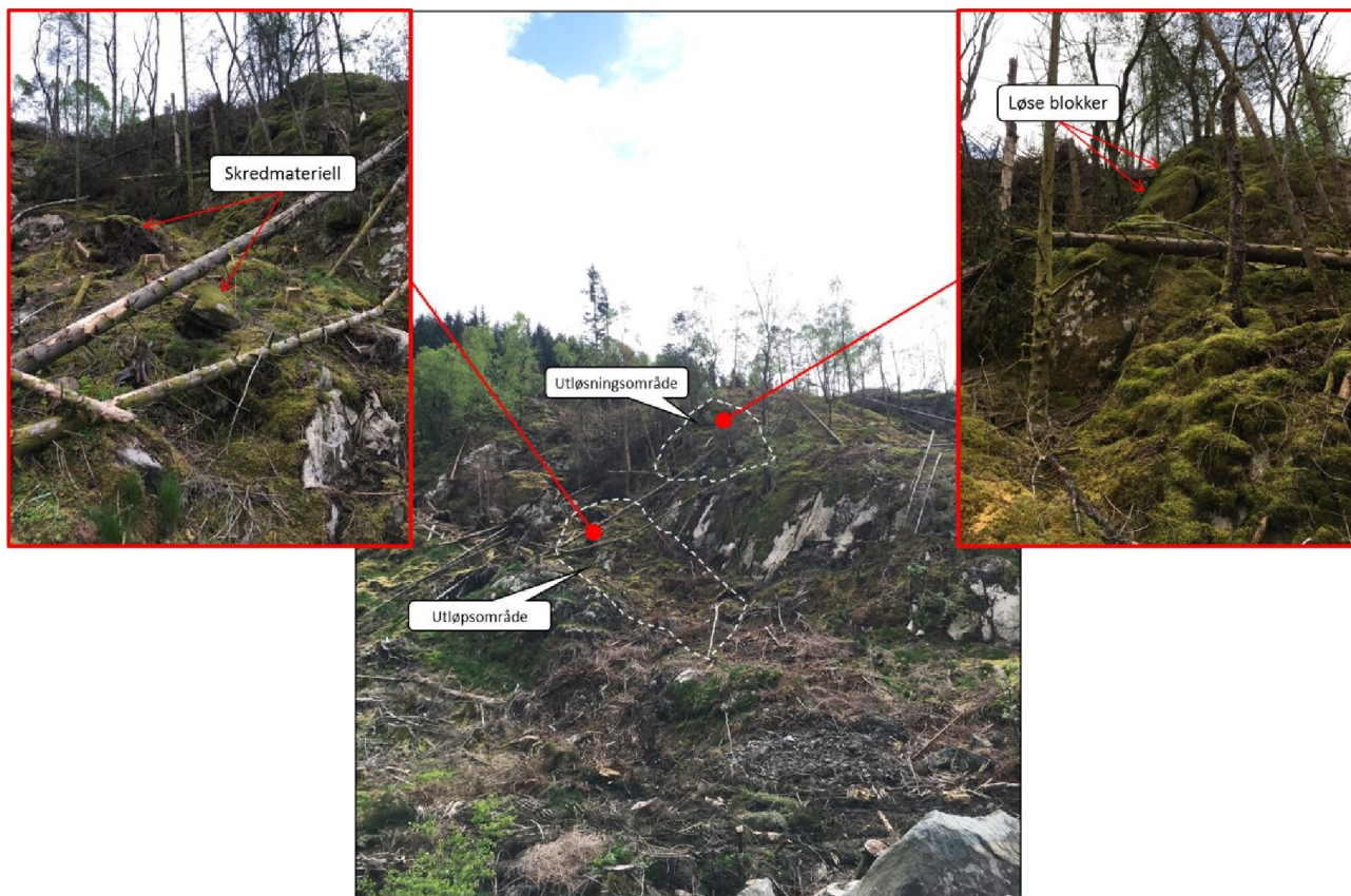
Figur 8. Foto fra befarings. Bildet i senter, viser området hvor det er registrert løse blokker og området hvor det er registrert skredmateriell. Bildet oppe til venstre viser blokker som har falt ut fra skråningen (historiske skredhendelser). Bildet oppe til høyre viser området hvor det er registrert løse blokker.
