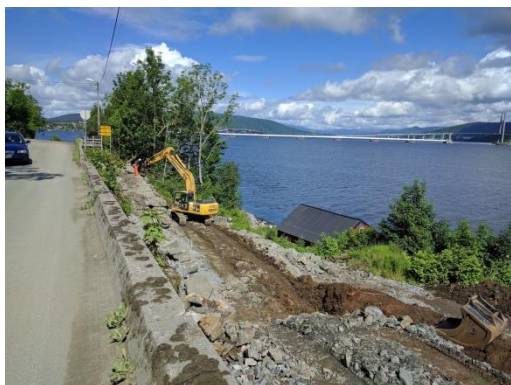
Bygging av ny gangveg til Frekhaug kai
