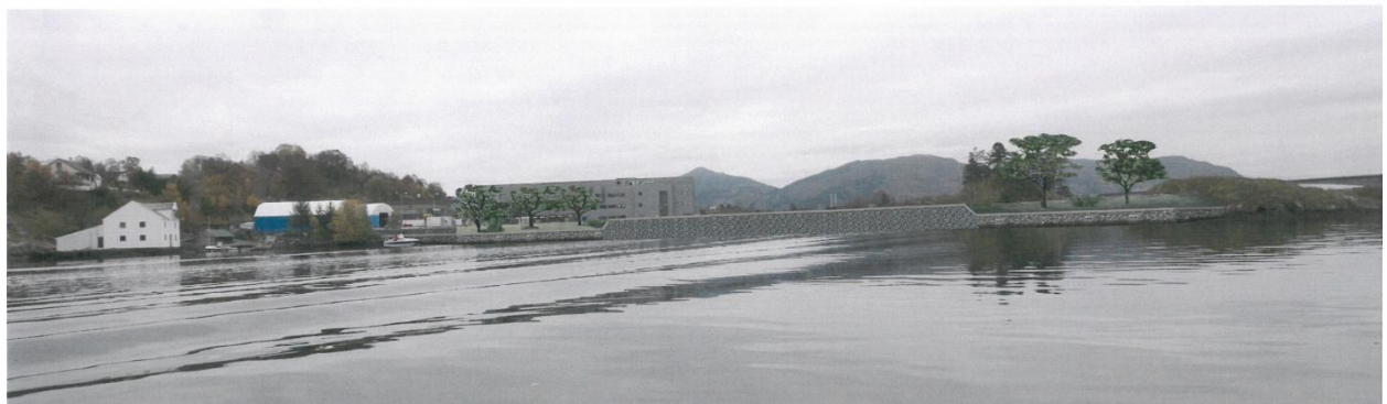
Sett fra nord - ny situasjon
