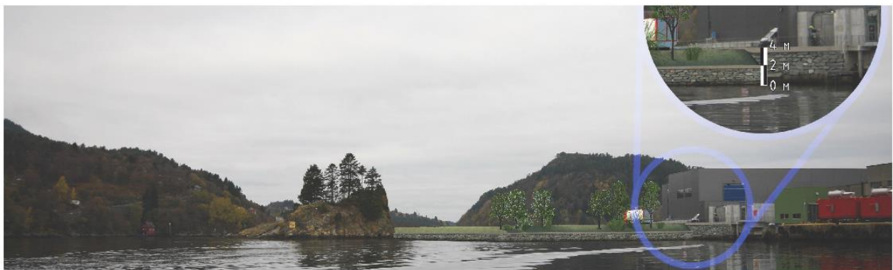
Sett fra sør - ny situasjon
