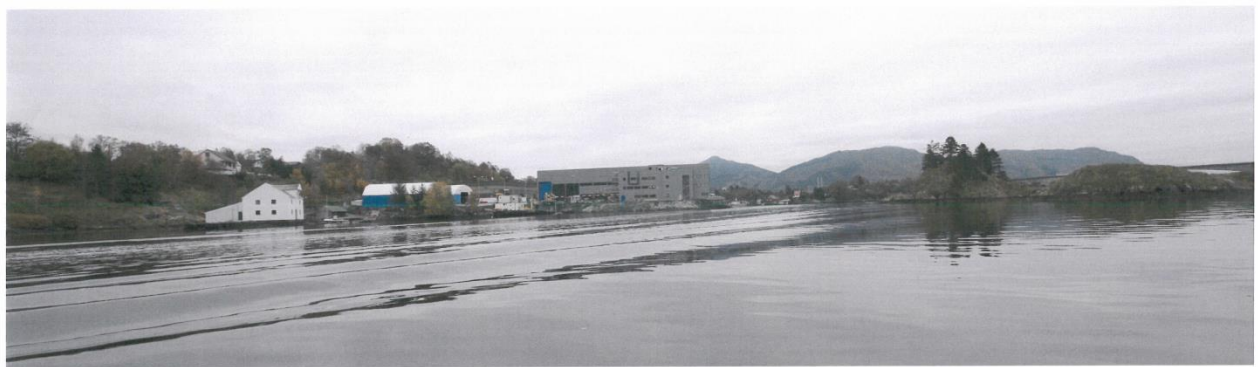
Sett fra nord - eksisterende situasjon
