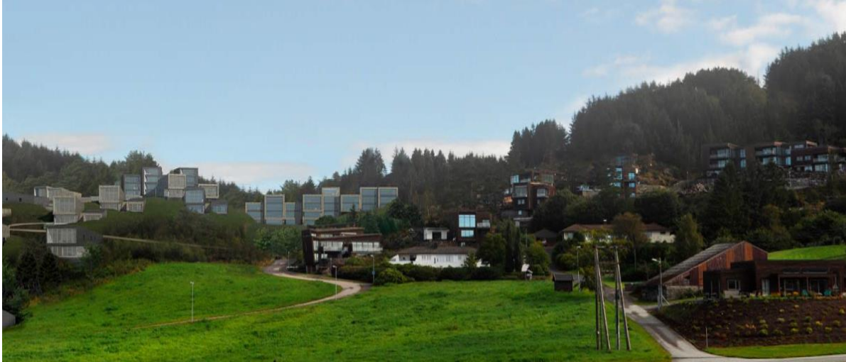
BBB2 til venstre i bilete, BBB1 i midten og eksisterande busetnad til høgre. (Arkitektkontoret Børtveit & Carlsen AS)
