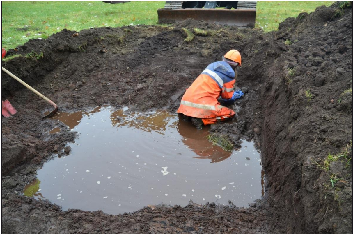
Figur 20. Oversynsbilete teke i sjakt 1 på eigedom gnr. 26, bnr. 5 (område 1). Som ein kan sjå står grunvatnet svært høgt. Sjakta vart avslutta då vi støtte på enden/starten på ein større veite, difor store mengder vatn.
