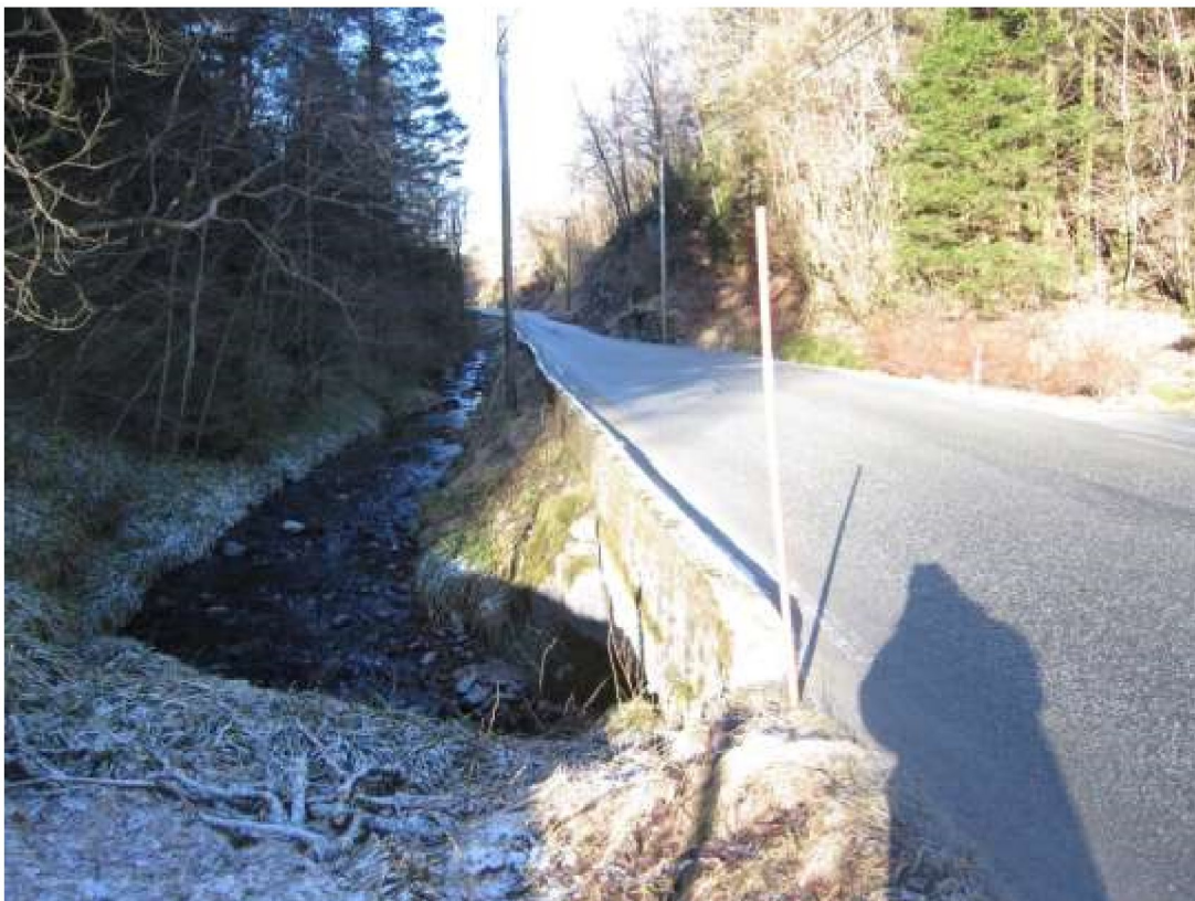
Figur 3; Oppstrams brua over Ådlandsbekken.
