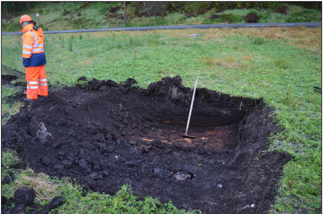
Figur 28. Viser undergrunnsforhold i område 3 (Sjakt 13A).
