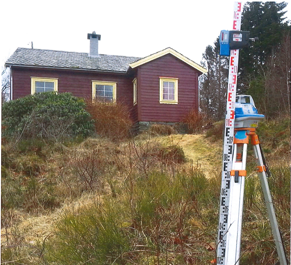
Figur 4: Nivellering - høyde målinger utført i terreng m/rotasjonslaser (3. Februar 2018).
