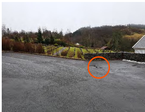
Figur 9: Sluk som er gått tett, plassering på P-plass ved kyrkjestova. Sluk vist med raud sirkel.
