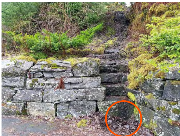
Figur 6: "Trapp" nedanfor bekk, med retning ned mot sluk på parkeringsplass. Sluk vist i raud sirkel.
