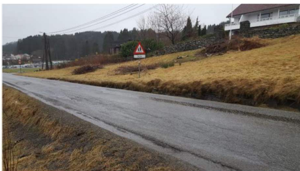
Figur 3-9: Bilde tatt nordvestlig retning mot stigende veipel nr. Endeavslutning av mur.
