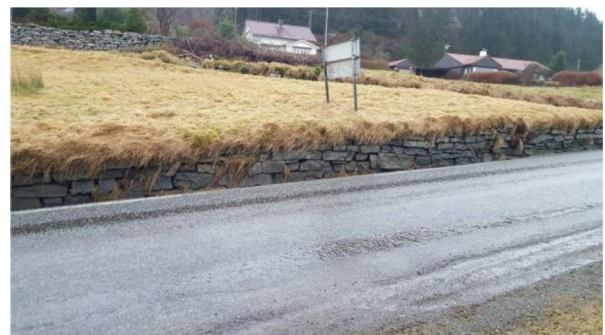
Figur 3-10: Bilde tatt mot nord. Viser midtre del av mur.
