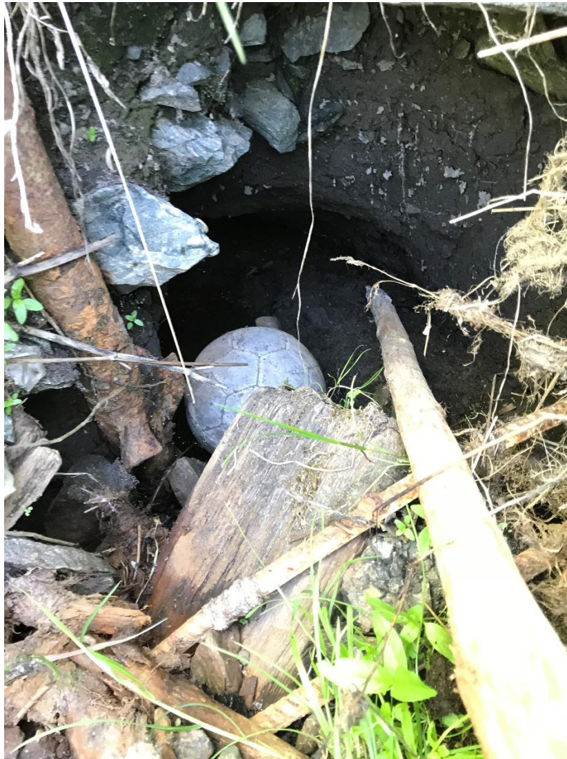
Bilde 2: Viser inntaket i lavpunktet ved ca. profil 850 i Fv. 244.
