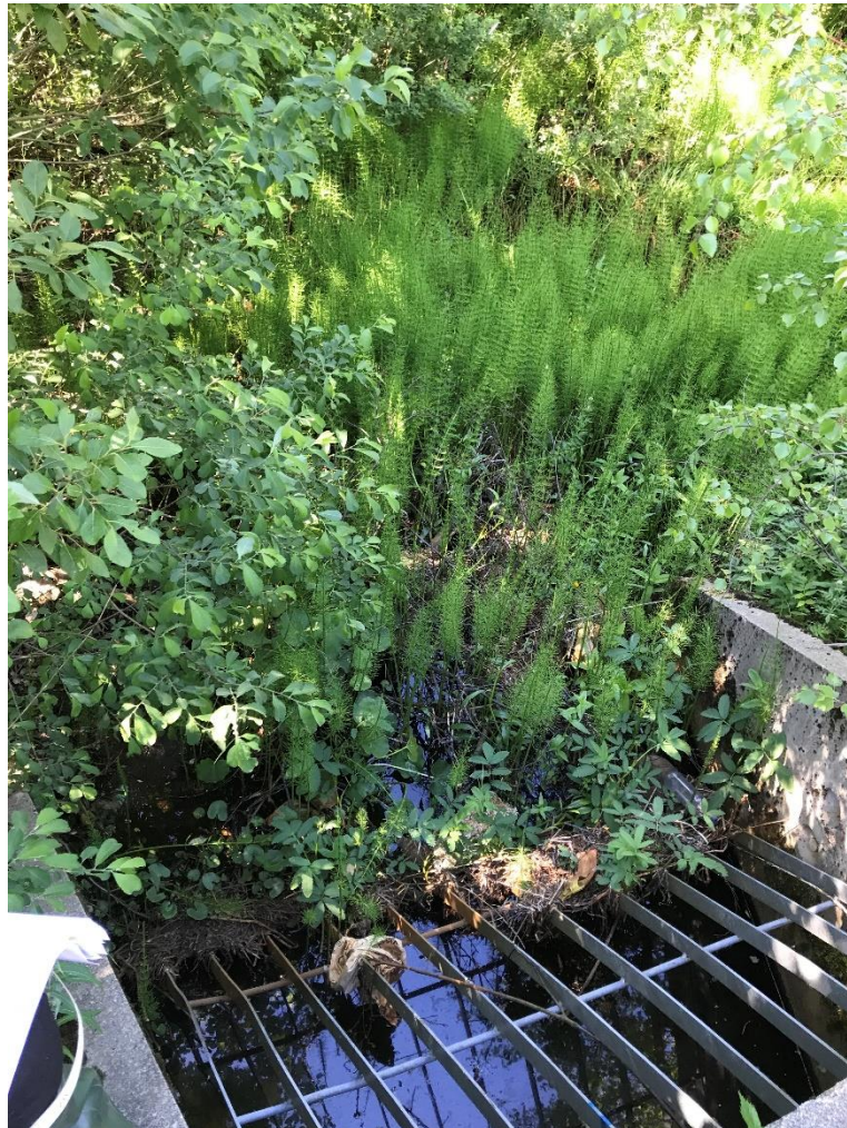
Bilde 4: Viser inntak til DN1000-overvannsledningen fra myren nord for Frekhaug terminal.
