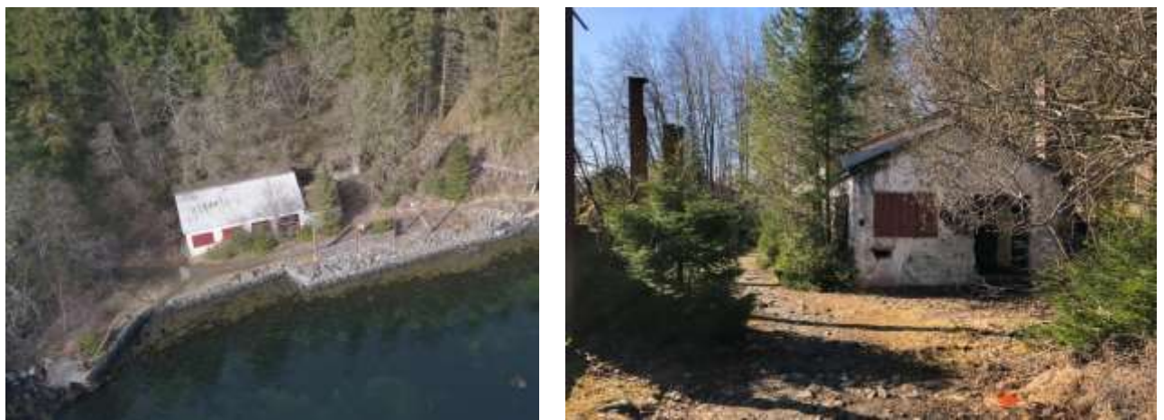
Figur 2-4: Foto til venstre er tatt med drone, og viser kaiområdet foran gjenværende bygning. Foto til høyre viser gjenværende bygning, med gjenværende betongmur med stålkonstruksjoner rundt bygningen. Foto: Multiconsult
