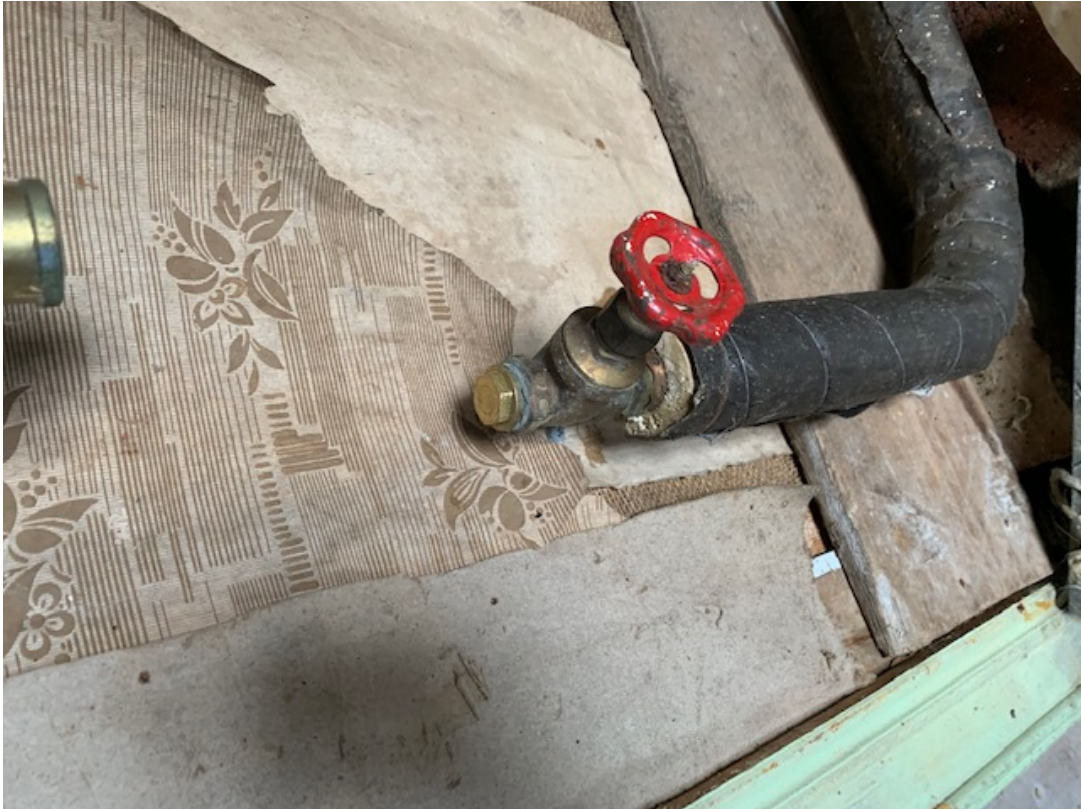
Skjema: "Sjekkliste etter utført arbeid: Plugget vanntilkobling." Beskrivelse: IMG_1059, Filnavn: IMG_1059.jpg
