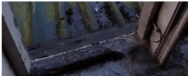
Bildet over: Vinduskarm 2.etg
