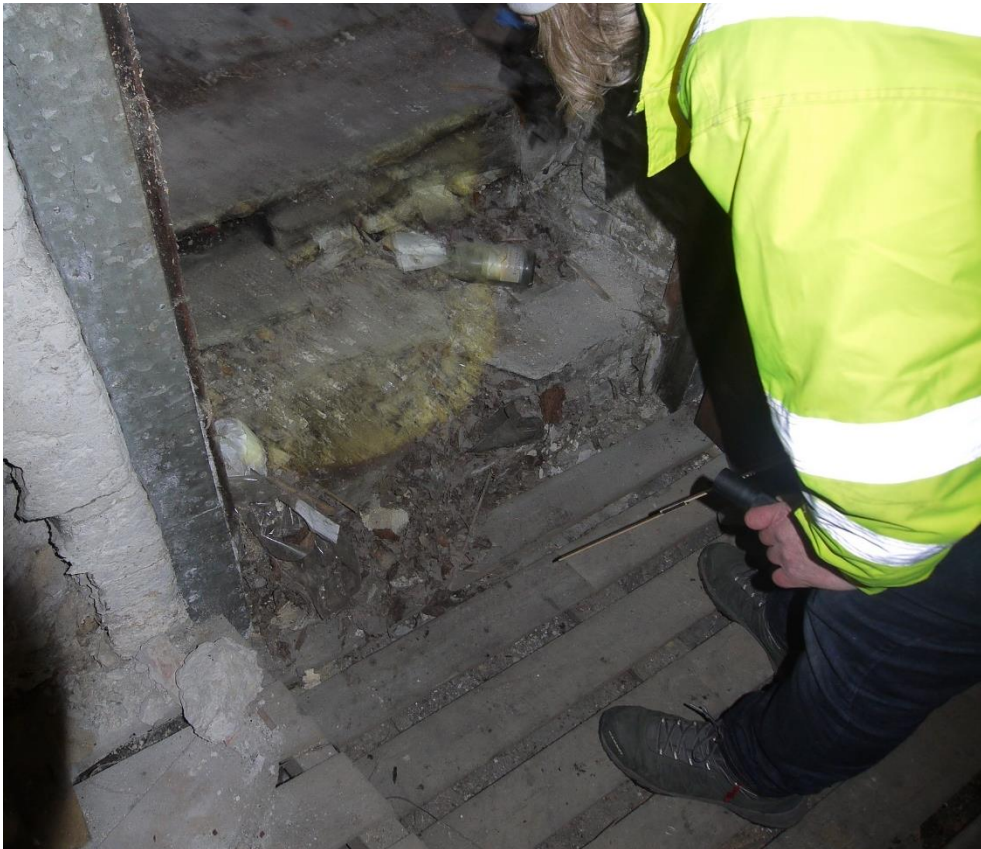
Bildet over: grunnforhold ved inngang til kjeller
