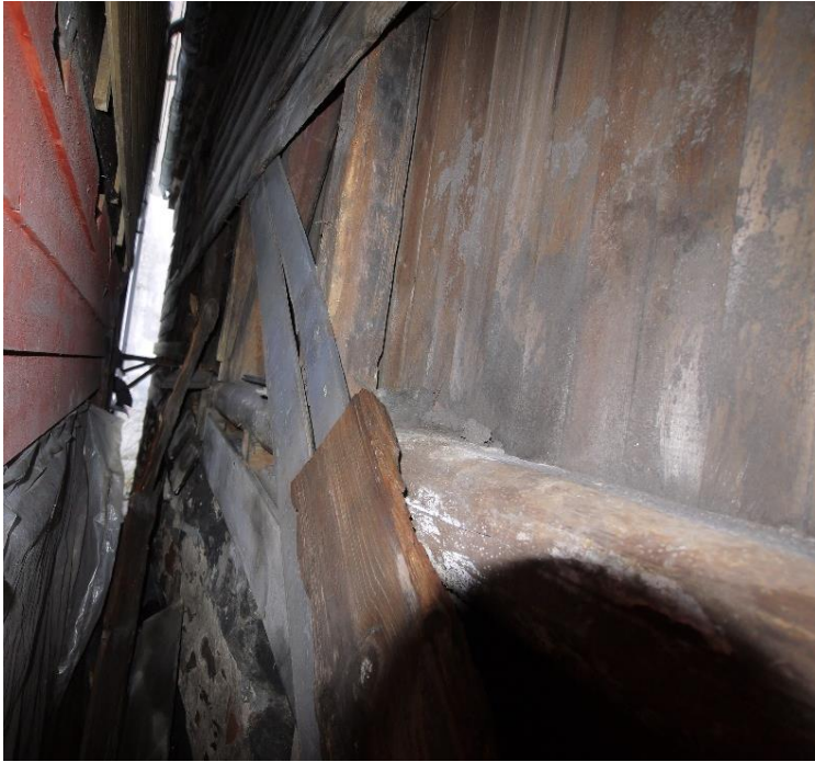
Bildet over: Overgang kjellervegg/trebygning
