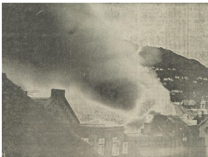
Brann i taket på Cort Piilsmauet 12
