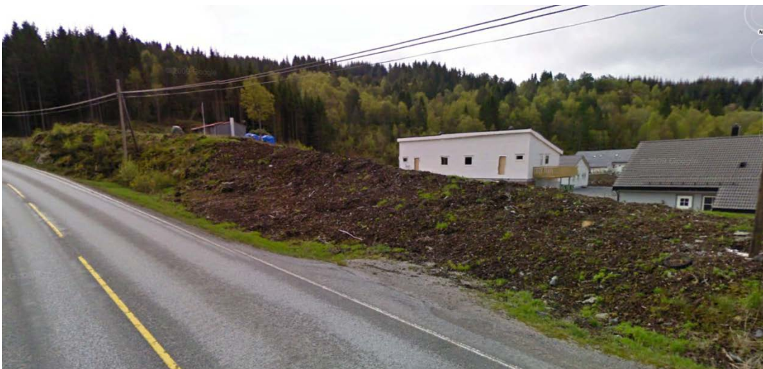
Figur 37. Bilde frå Google Earth som viser støyvoll oppført som avbøtande tiltak i gjeldande plan.
