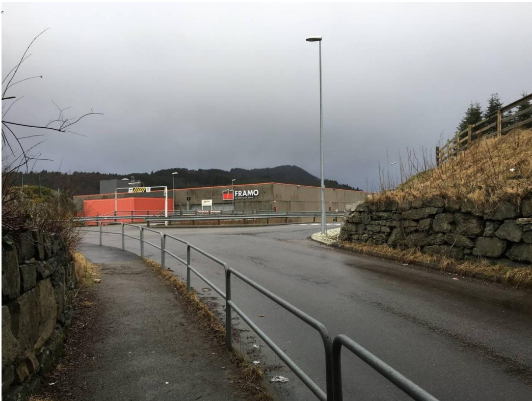
Bilde 4: Kryss ved kulvert/undergang under E39
