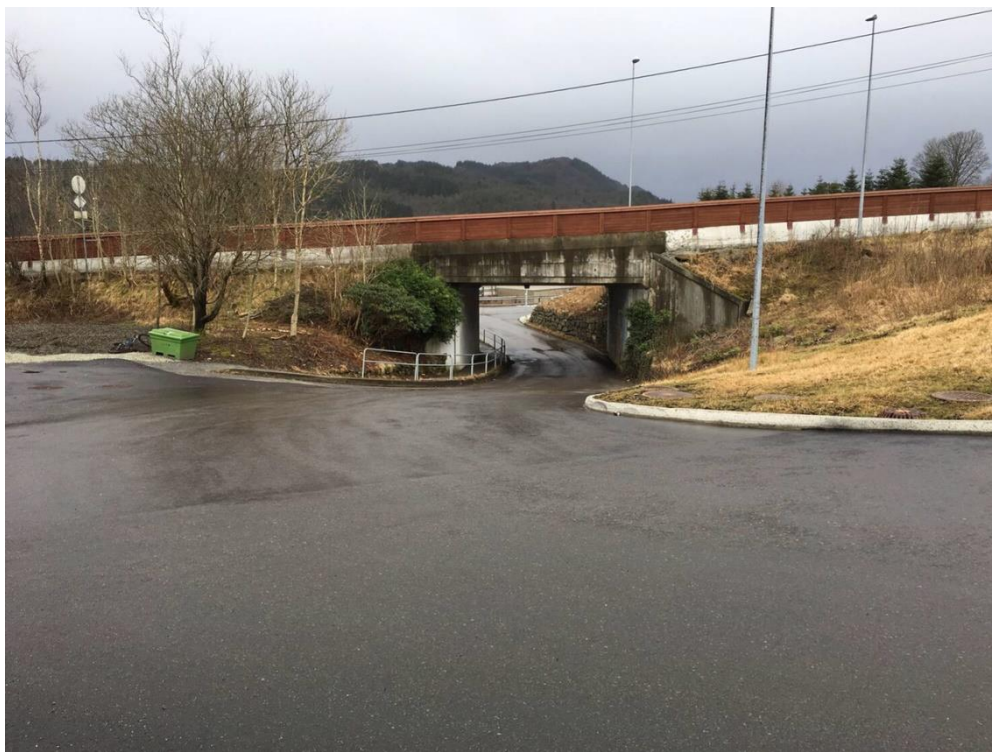
Bilde 3: Kulvert/undergang under E39
