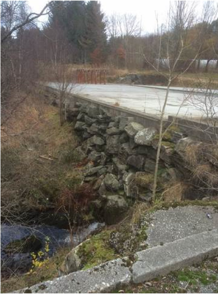
Figur 2 Innløp kulvert ved myra nord for fylkesvegen (bilde tv) og utløp kulvert som går under fylkesvegen (bilde i midten). Det siste bilde viser utløp vest for planområdet.
