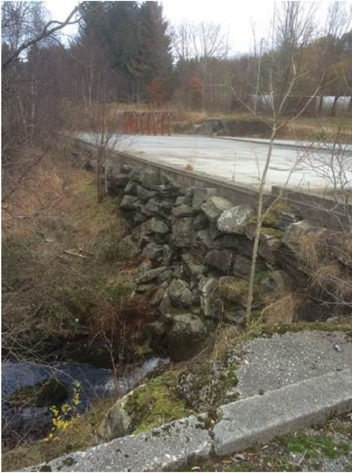
Figur 2 Innløp kulvert ved myra nord for fylkesvegen (bilde tv) og utløp kulvert som går under fylkesvegen (bilde i midten). Det siste bilde viser utløp vest for planområdet.
