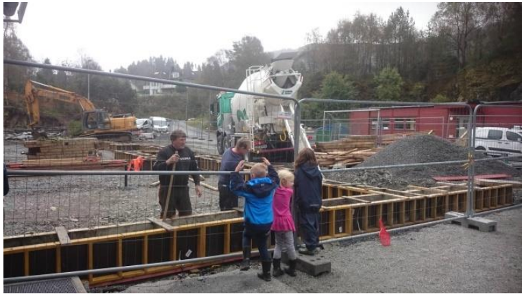
(det var spanande å følgje med då ringmuren vart støypt)
