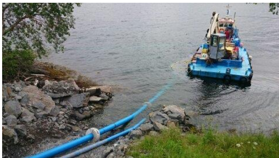
Frå Prosjekt 600 Vassleidning i sjø, Ådlandsvågen - Landsvik
