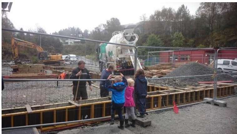
(det var spanande å følgje med då ringmuren vart støypt)
