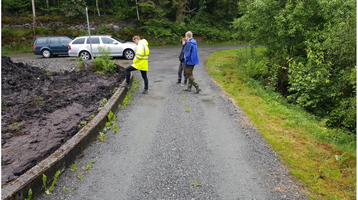
Fig. 4. I dette området kryssar bekken ein veg før den held fram i sitt naturlege leie nedstraums kulverten.
