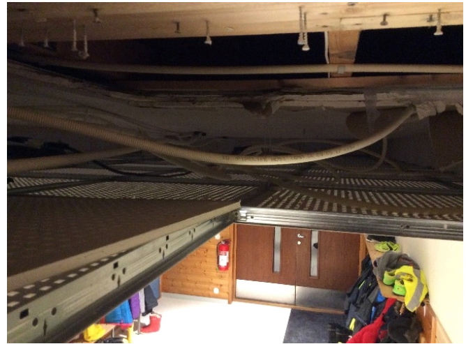
Viser hulrommet mellom letthimling og brannhimling.
