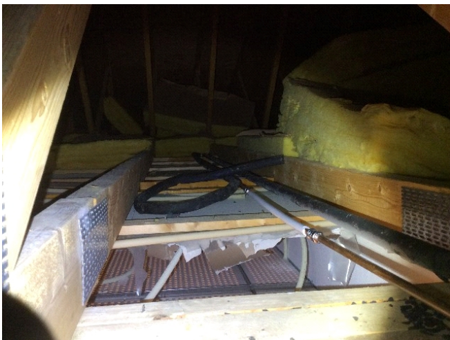
Viser hvor røret ligger i bjelkelaget over brannhimlingen.
