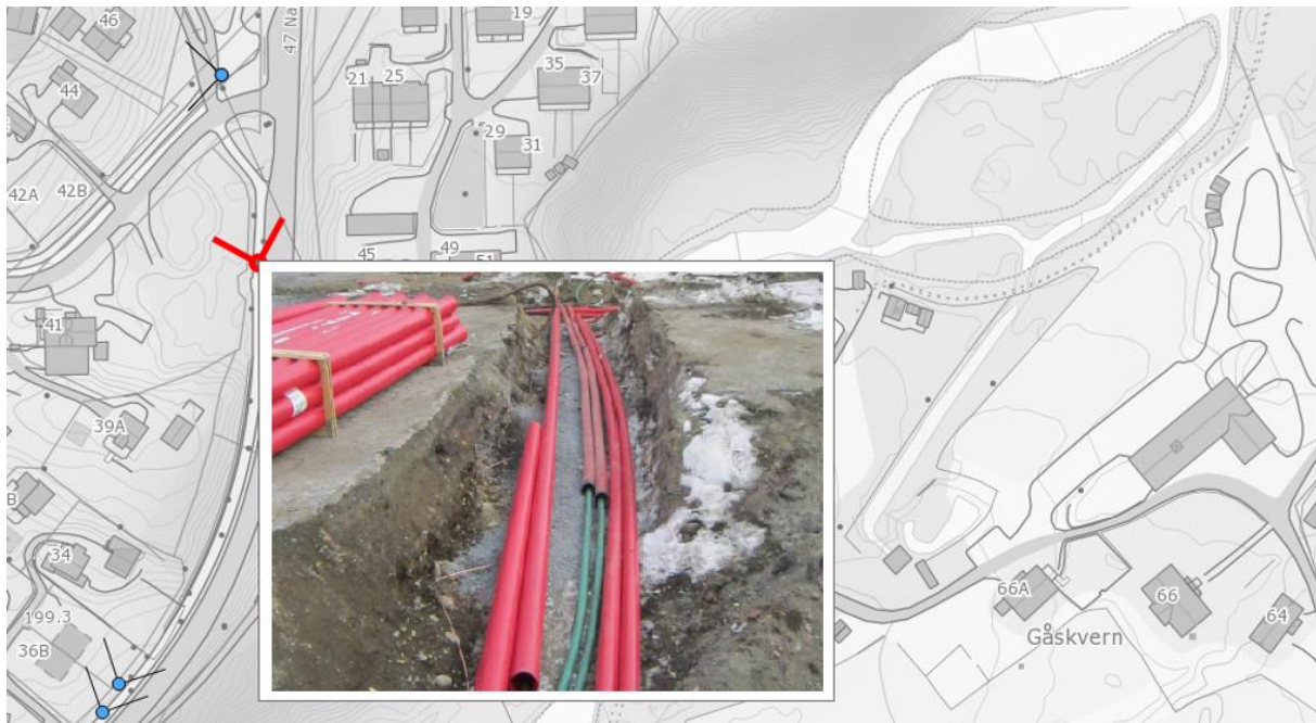
Figur 28: Alle anlegg som legges i bakken skal dokumenteres med georefererte bilder
