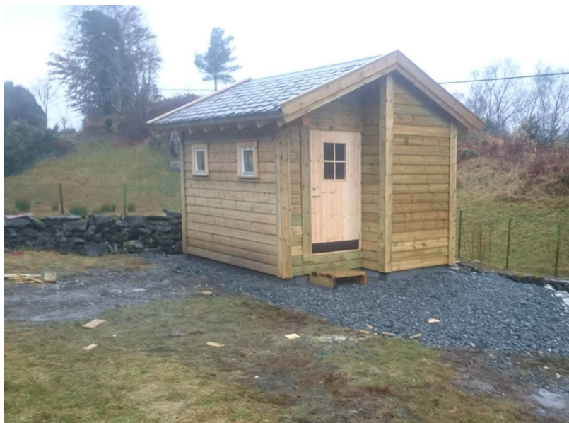
Bod ferdig oppsatt, maling gjennstår.
