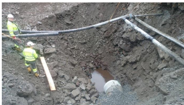
Ny overvasskulvert under Mjåtveitvegen ved Paktamyra
