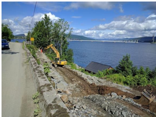
Bygging av ny gangveg til Frekhaug kai
