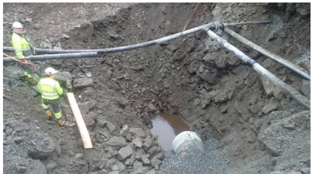
Ny overvasskulvert under Mjåtveitvegen ved Paktamyra
