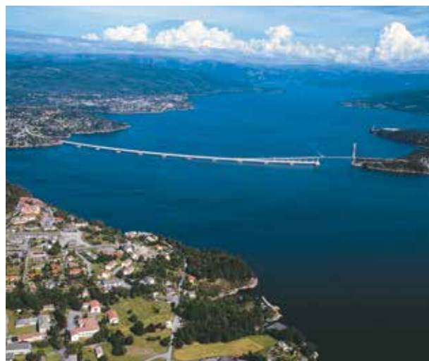
Brua over SALHUSFJORDEN(2000)
