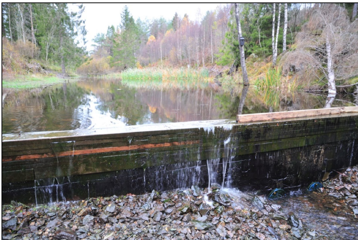
Figur 2: Damkonstruksjonen i renseseparken ved Sveåsen, 16.10.18. Vann passerer både over og under dammen.
