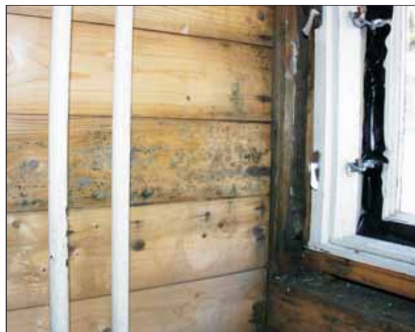
Muggvekst som en følge av kondensering av varm, fuktig luft på kalde flater.
