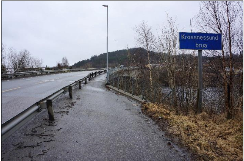
Gang-/sykkelveg i retning mot Holsnøy, over Krossnessundbrua.
