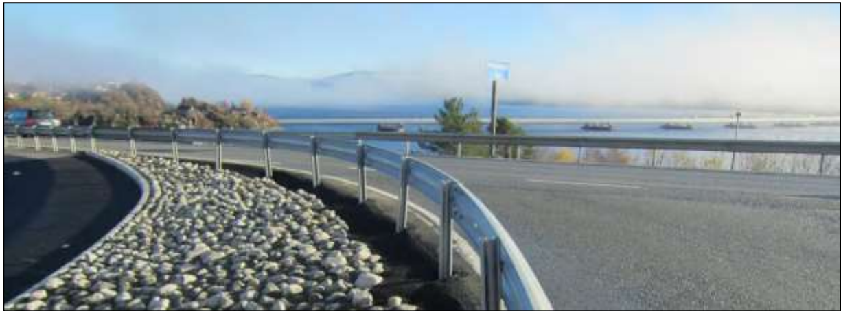
Figur 10; Frå fv 564 og Fossekrysset. I bakgrunnen ser ein Nordhordlandsbrua over til Flatøy.
