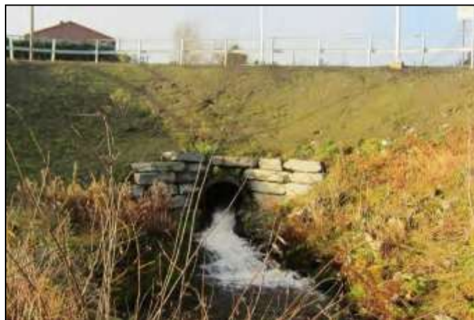
Figur 25; Utløp frå stikkrenna under Ådlandsvegen ved Fossekrysset.
