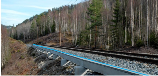
Figur 3.2. Kanal anlagt på grunnen langs jernbane, egnet til framføring av andre infrastrukturanlegg som f.eks. ekom.
