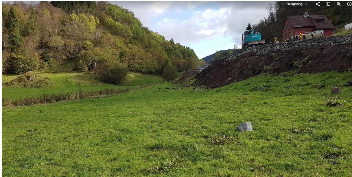
Bilde syner korleis teigen mellom gravemaskin og bekk vert veldig bratt dersom ein ikkje kan leggja skråninga over bekken.
