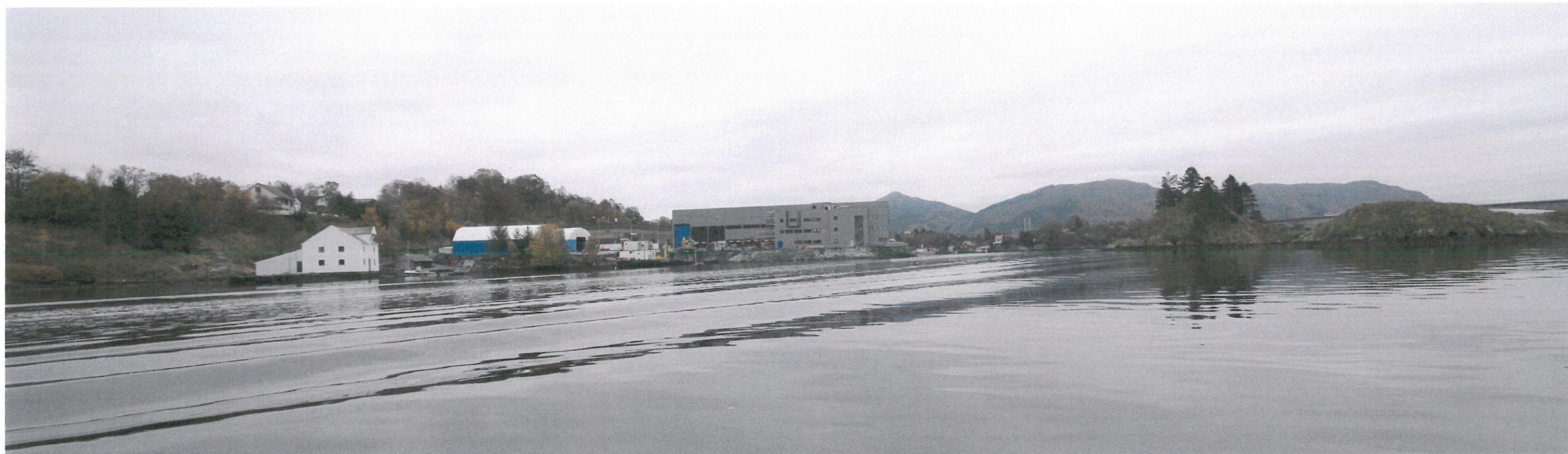
Sett fra nord - eksisterende situasjon
