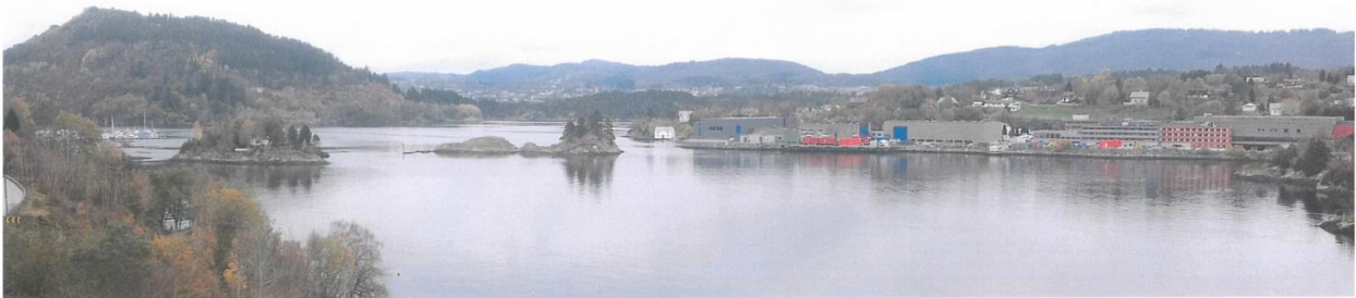
Sett fra Krossnessundbrua- eksisterende situasjon
