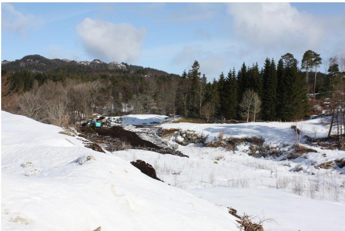
Jordpåfylling på Mjåtveit
